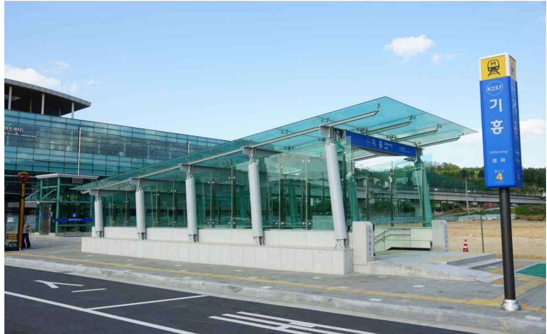
분당선 기흥역 지하출입구 Canopy
