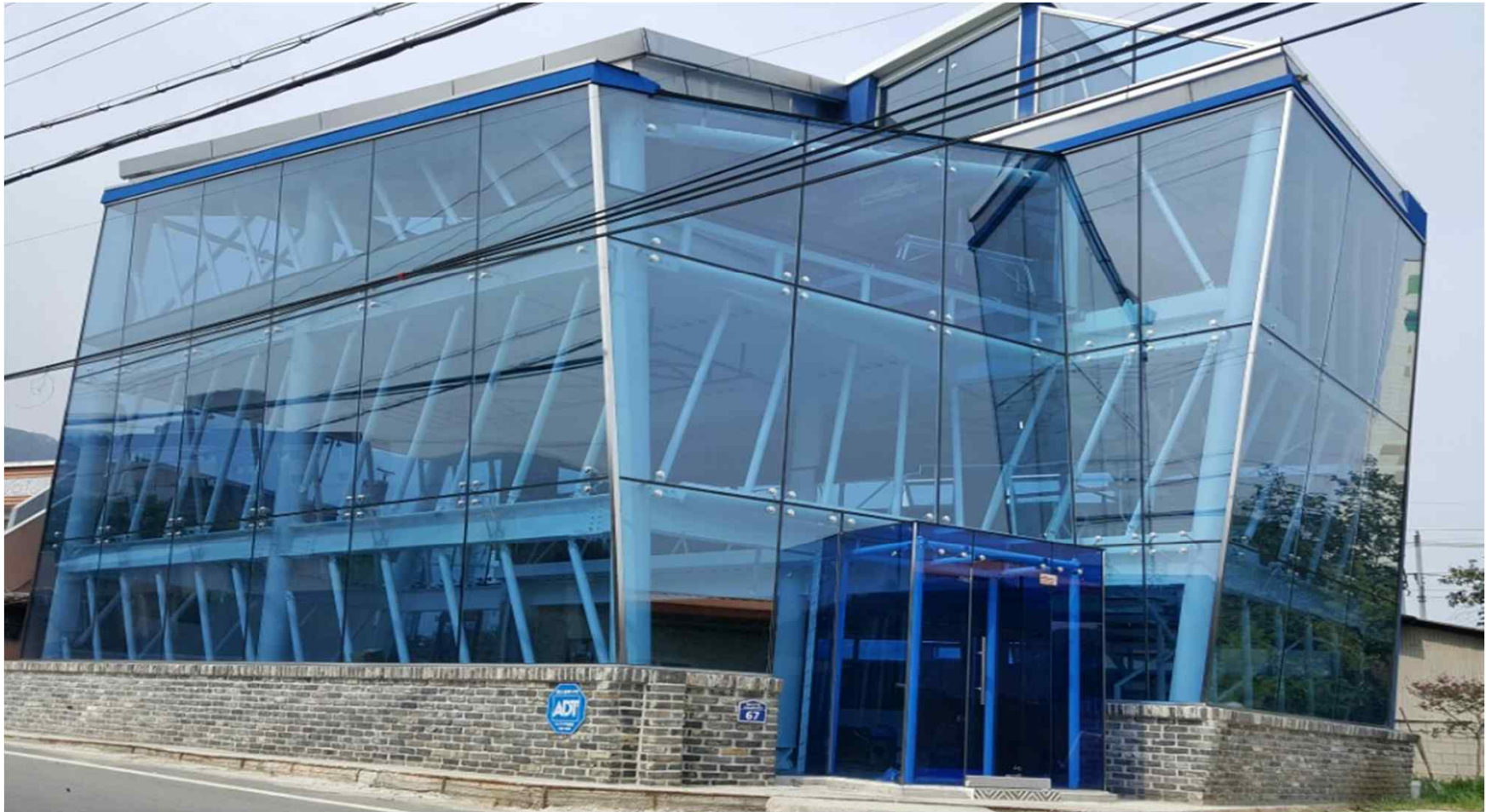
청도 고수리 상가주택 - PIPE TYPE 전면
